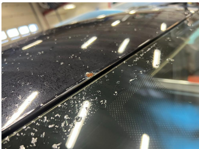
1.2 Normal bruksslitasje innvendig og utvendig
