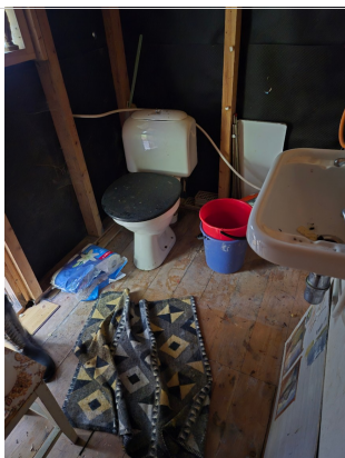
Synlig stenderverk på bad.
