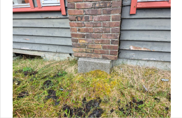
Betong grunnmur, samt betong fundament for skorstein.
