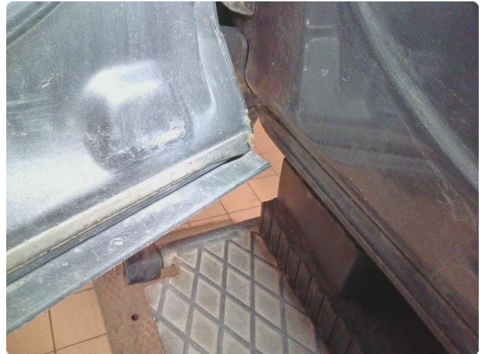
1.1 Rust i fals
