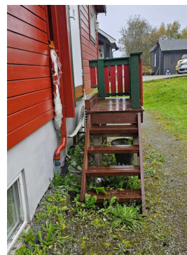
Utvendig trapp til tilbygget stue
