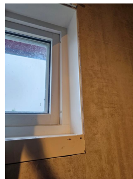
Vindu i våtsone i dusj, Treverk i våtsone i dusj
