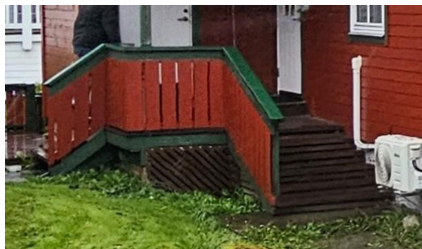
Trapp til inngangsdør på hovedplan
