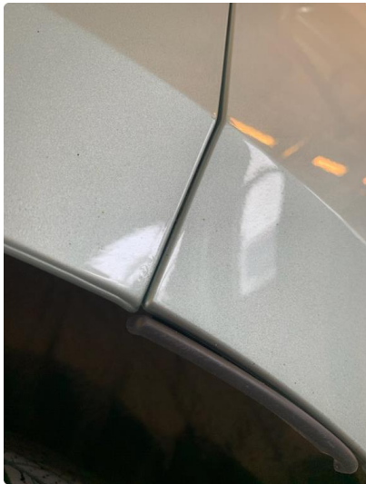
1.3 Liten steinsprut med korrosjon.
