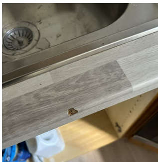
Skade på laminert benkeplate
