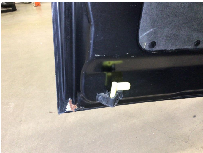
2.3 Noe overfladisk korrosjon i dører
