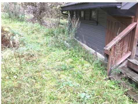
Terreng faller inn mot fritidsboligen
