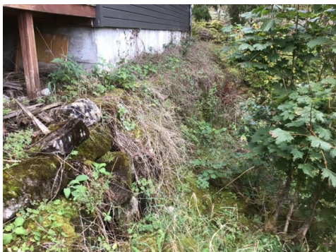
Forstøtningsmur langs kjellervegg
