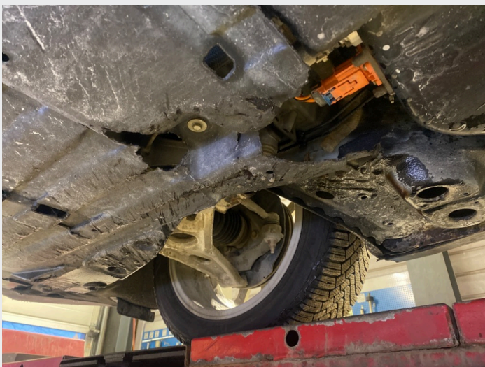
2.2 Plate under motor er skadet på flere steder
