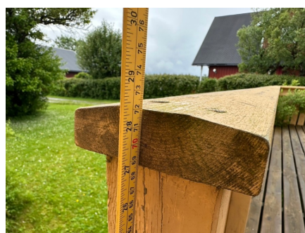
Rekkverks høyde 72cm.
