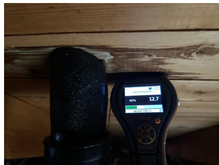
Fuktkvotemåling målt 12,7v% ved gjennomføring av avlufting til avløpsrør. Noe som er tørt. Måling utført med MMS 2 med pigger, korrigert for nordisk tre.
