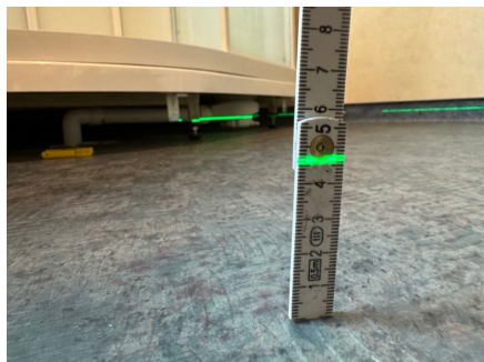
80cm ut fra sluk er gulvet 2mm lavere en sluk.
