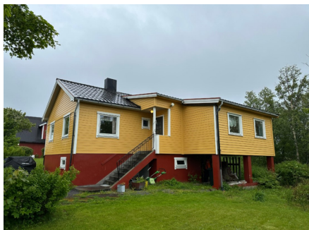
Snøfanger bør monteres over trapp
