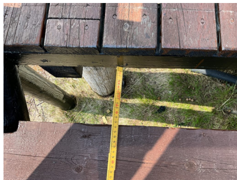
Horisontal avstand mellom trapp og terrasse
