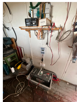
Anlegg for lagring og distribusjon av strøm fra solcelle
