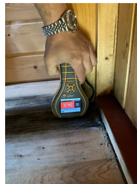
Fuktmålinger i gulvoverflate ved bakdøra
