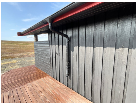
Taknedløp til terrassens
