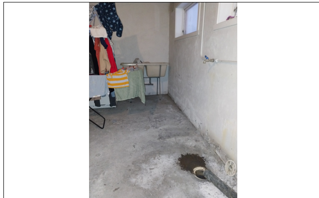
Vaskerom i kjeller
