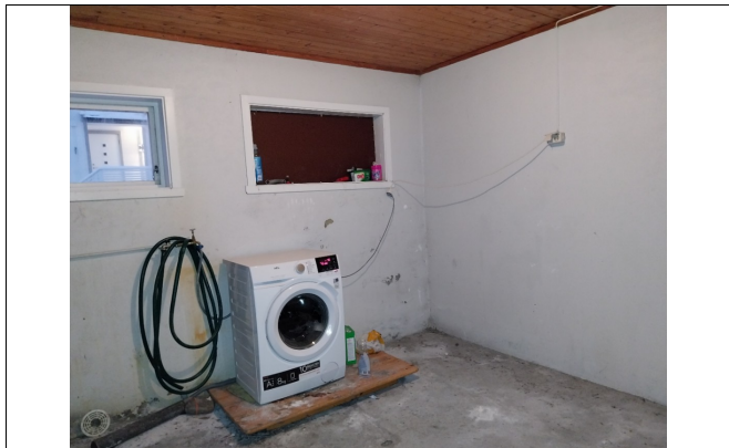
Vaskerom i kjeller
