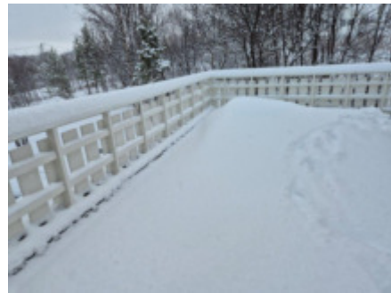
Veranda over garasjetak.
