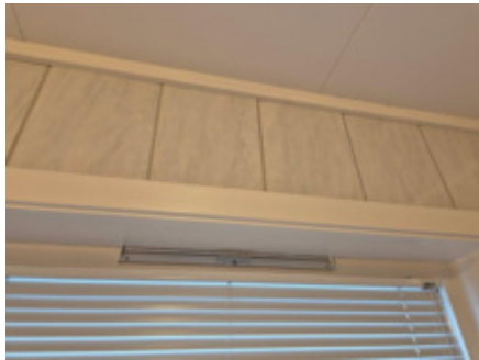
Spalteventil i vindu.
