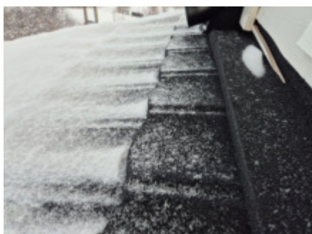
Tak er tekket med takpanner.
