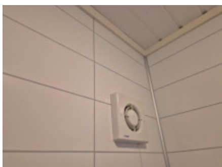
Veggmontert avtrekksvifte.
