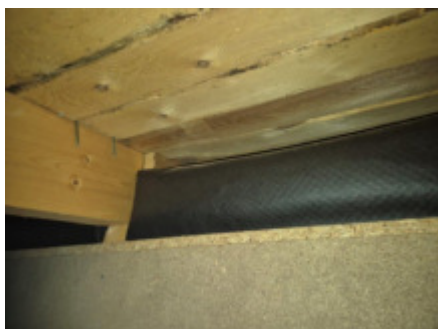
Luftespalte i isolert skråtak/himling.
