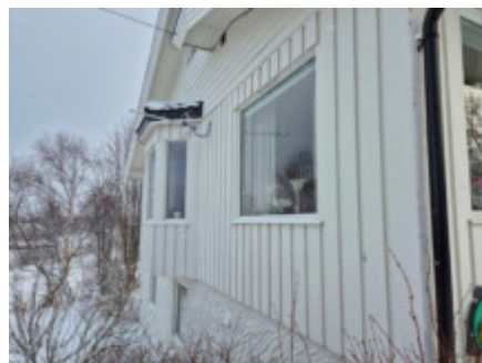
Utvendig kledning av malt tømmermannspanel.
