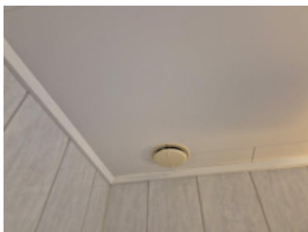
Himlingsplater i innvendig tak og fliser på vegger.
