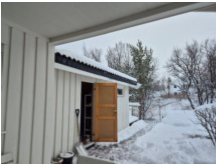
Veranda med utgang fra stue.
