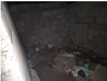
Kryp kjeller under deler av boligen.
