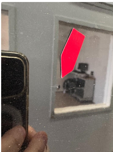
1.2 Liten steinsprut med korrosjon.
