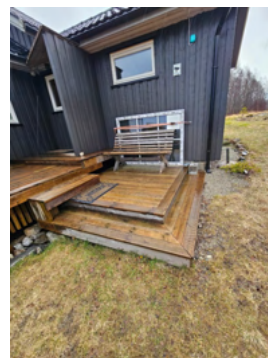
Manglende rekkverk ved platt ved inngang
