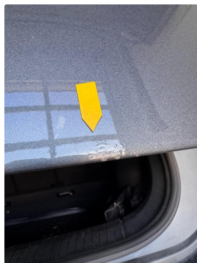
1.4 Noe sår med korrosjon.
