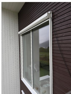
Screens på vindu og skyvebalkongdør.
