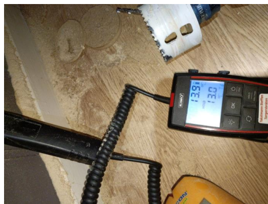
Rf-måling i dusjvegg.
