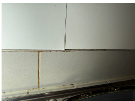
Tegn til fuktsvelling i nedrekant av baderomsplaten. Misfarging i fuger
