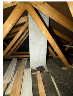
Oversikt takkonstruksjon ved pipegjennomføring
