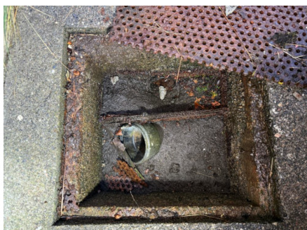
Sluk ved krypkjeller
