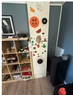
Pipe sett fra stue underetasje. Hull tettet med blindlokk
