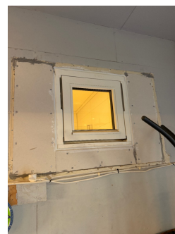
Uferdig omramming vindu fra bad mot garasje.
