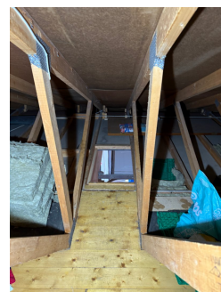
Luke for tilkomst til kaldloft sett fra loft.
