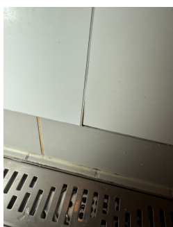
Tegn til fuktsvelling i nedrekant av baderomsplaten. Misfarging i fuger
