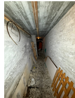
Tegn til saltutslag på nedre del av vegg sett fra bod.
