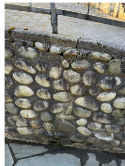
Mur på nordside ved innkjørsel. Sprekk i mur
