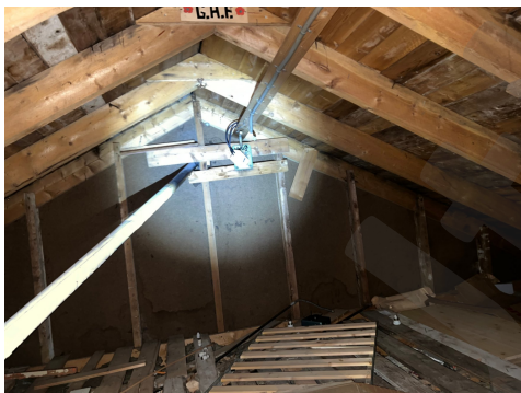
Løst hovededinnntak åpne koblingsboks (er)
