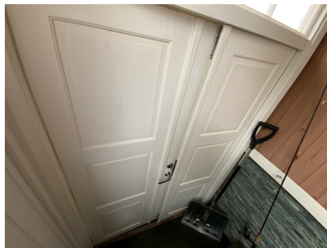
Stedvis utette tettepakninger
