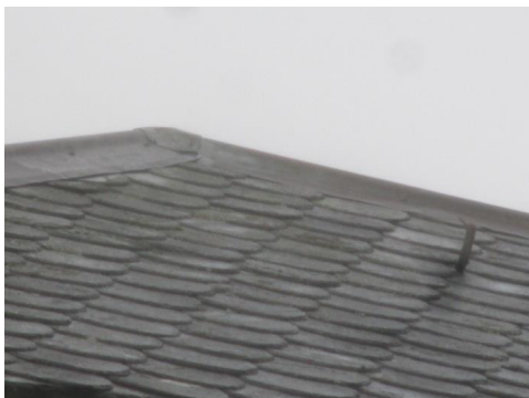
Deler av taktekkingen med beslag.
