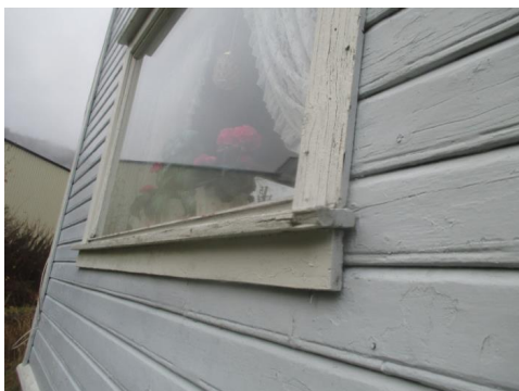
Deler av kledningen med tilhørende belistninger.
