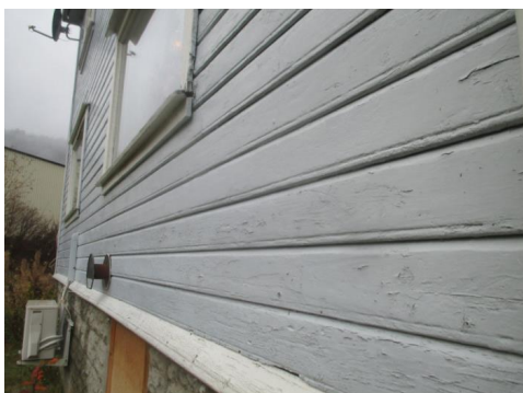
Deler av ene fasaden.
