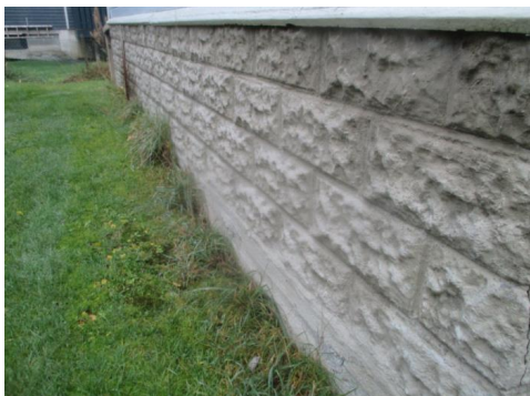
Deler av grunnmur.
