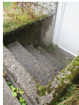
Forstøtningsmur for kjellertrapp.
