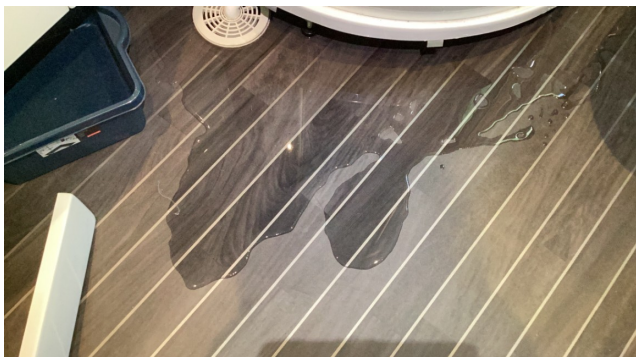
Vann renner fra sluk etter funksjonstesten
