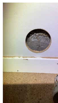
Ingen registreringer pga innforet vegg mot våtsonen vaskerom/tekniskrom pga lecavegg
