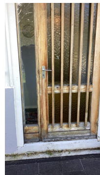
Ikke tett ytterdør som er klar for utskifting
