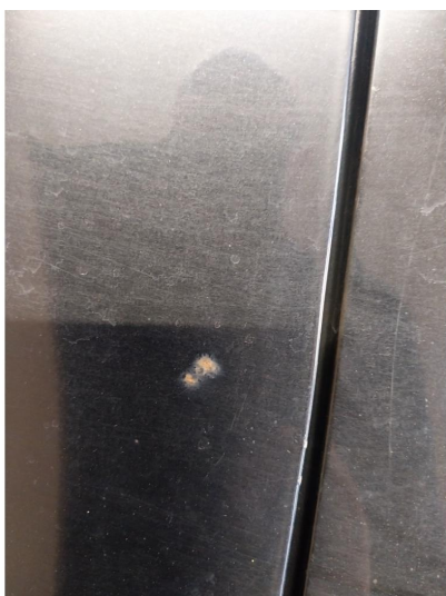
2.2 Rust/korrosjon
