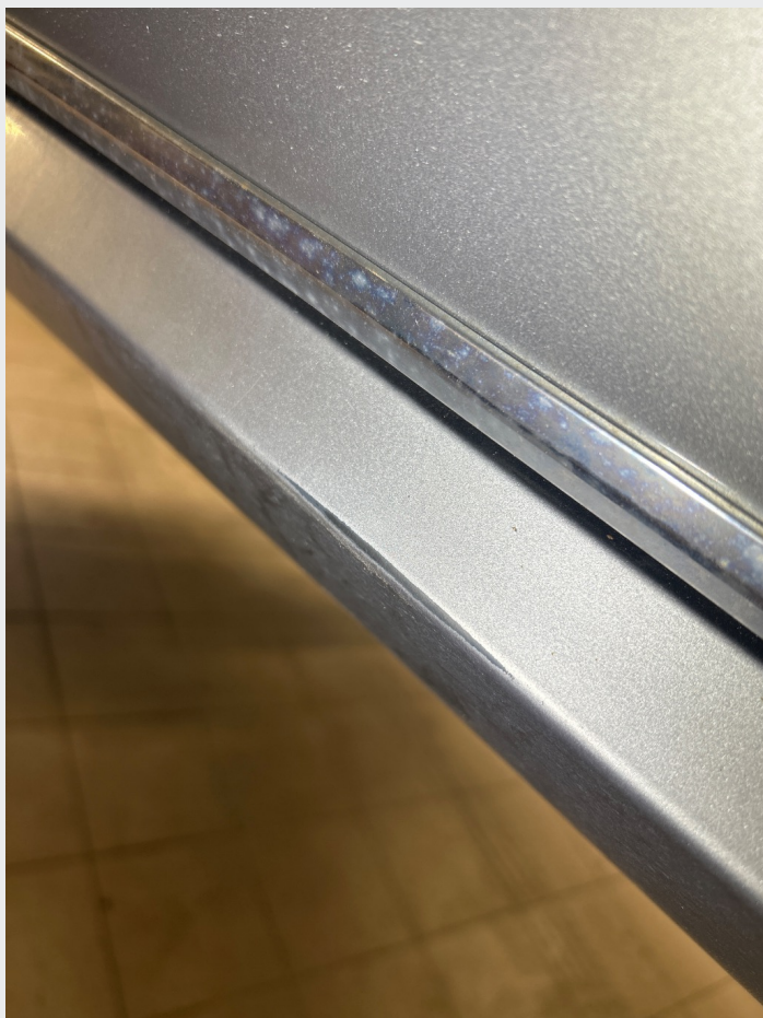
2.4 Skader i lakk på kanaldeksel v.s.
