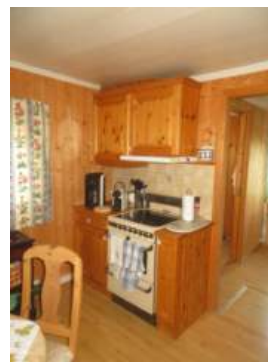
Kokesone med komfyr og avtrekksventilasjon.
