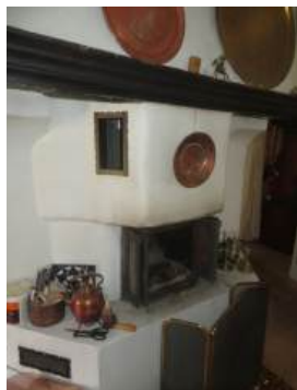
Peis i stue med støpejernsinnsats og murt omramming.
