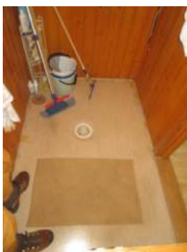
Del av bad - dusjnise med belegg til gulv og trepanel til vegger.
