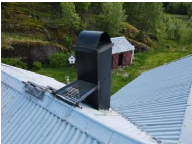
Skorsteinbeslag av metall over taktekke.
