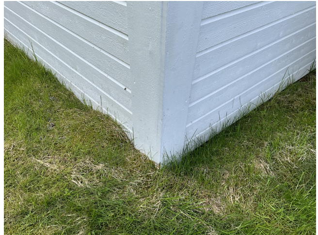
Kledning ha delvis for lite avstand til bunn.
