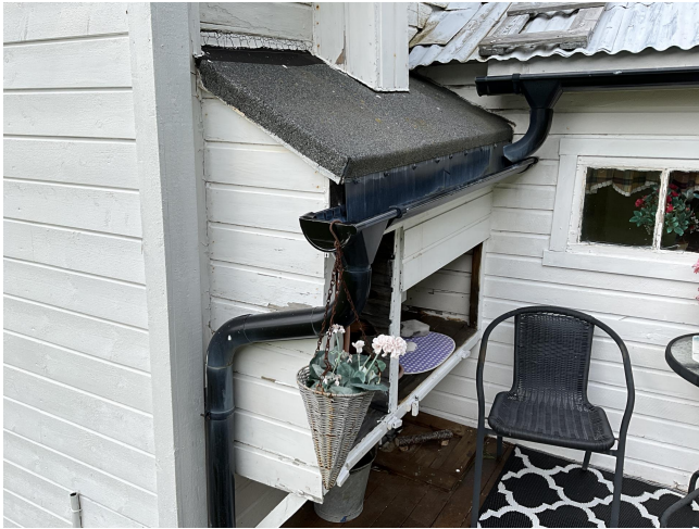
Takrenner og nedløpsrør av metal.
