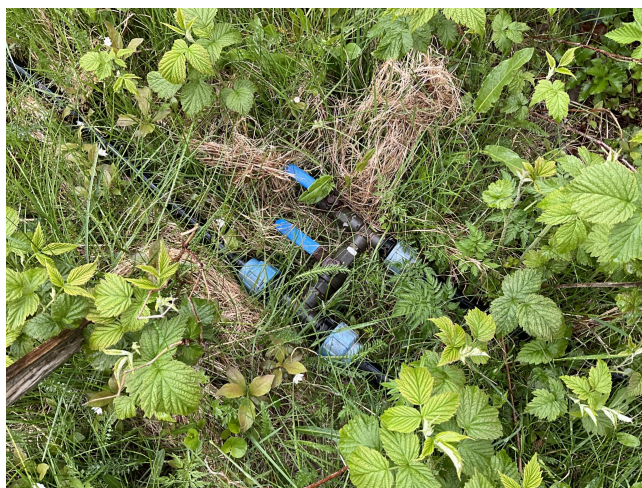
Hovedstoppekran er lokalisert og funksjonstestet.
