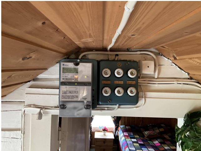
Digital strømmåler og 6 skrusikringer.
