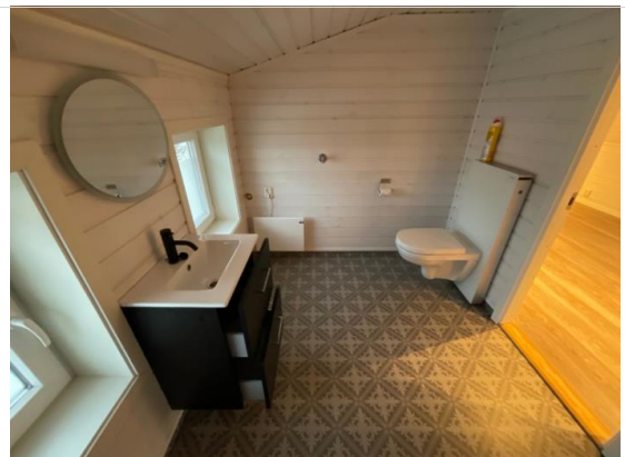
Veggmontert klosett og servant. Baderomsinnredning.
