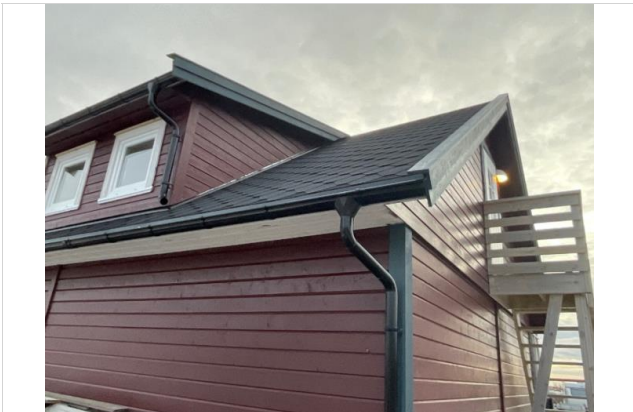
Utsnitt av takflate, yttervegg og takrenne/-nedløp.
