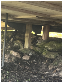
Søyle montert direkte på grunn.
