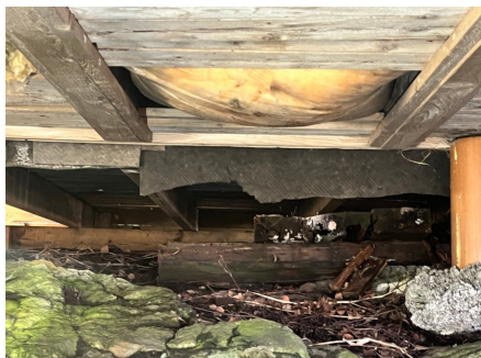
Råteskader på materialer som ligger under boligen
