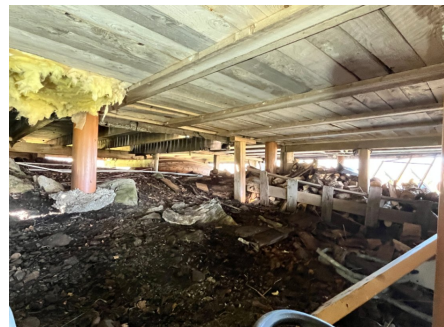
Søyle montert direkte på grunn.
