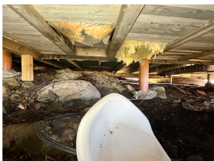
Råteskader på materialer som ligger under boligen
