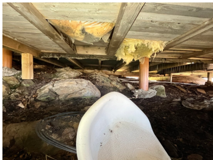
Søyle montert direkte på grunn.
