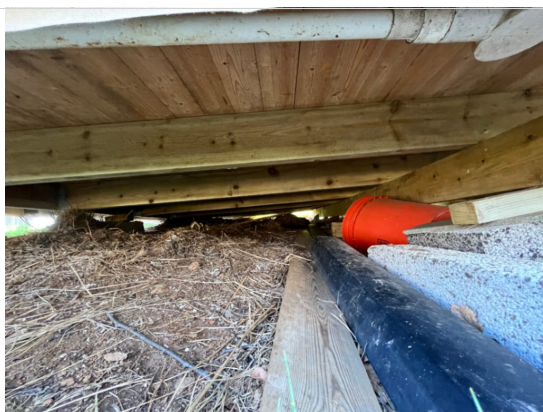
Uisolert gulv.
