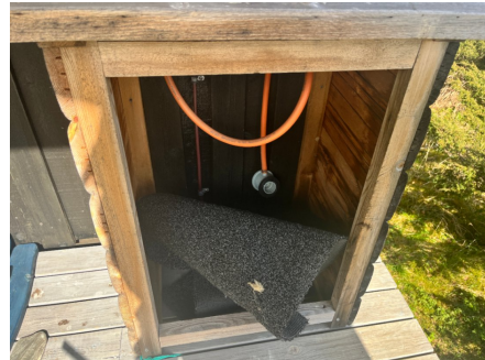
Utvendig skap for gassflasker
