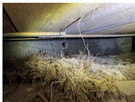
Krypkjeller under hytte med opprinnelig terreng på grunn
