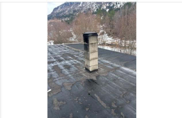
Røykpipe over tak.
