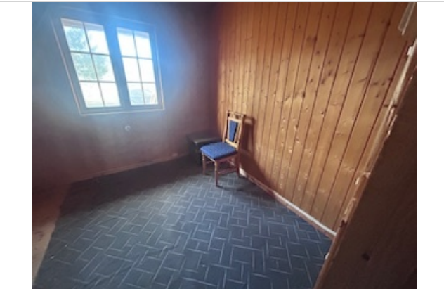
Trepanel i vegg og tak, teppegulv på spon på gulv.
