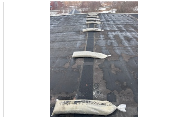
Stormsikring etter takrepsjon, pålagt vekt.
