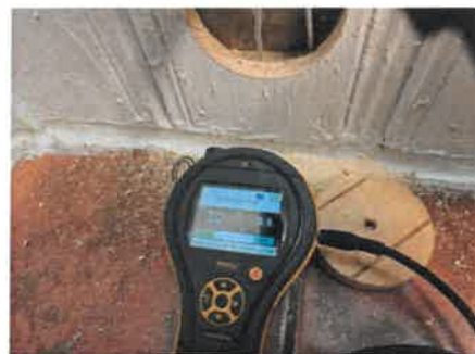
Fuktmåling i svill med tilfredsstillende resultat.
