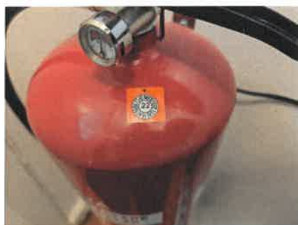
Pulverapparat i sokkel.
