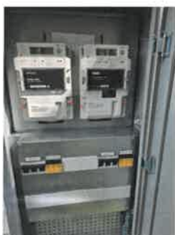
Utvendig inntak med separate målere.
