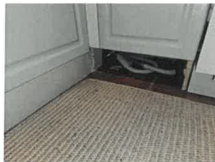
Mangler deler av sokkel.
