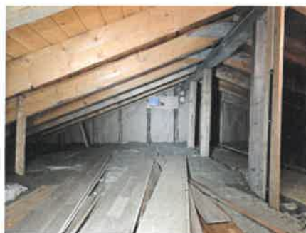
Bilde fra kaldloftet.
