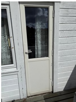
TG 2 Balkonger, terrasser og rom under balkonger
