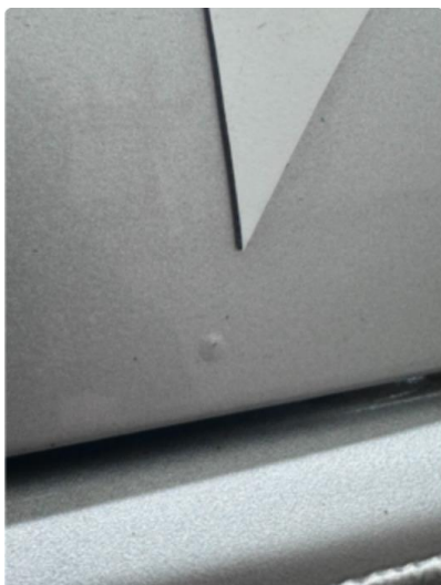
1.2 Steinsprut med korrosjon venstre og høyre skyvedør nedre del og høyre vindusramme fordør.
