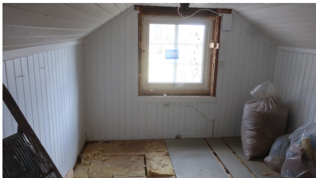
Gjenstående arbeide i soverom i andre etasje.
