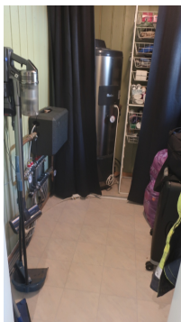
Teknisk rom med dobbeltmantlet v.v.bereder.
