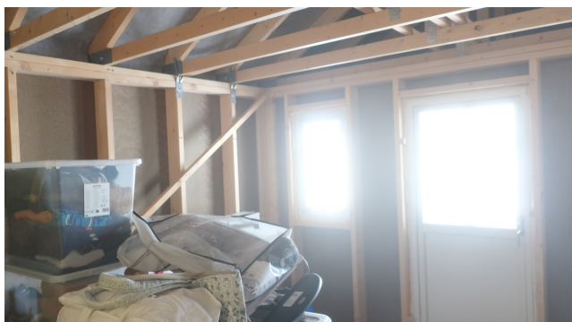
Rom i tilbygg i andre etasje.
