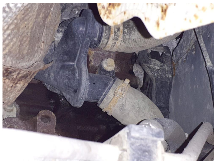
5.2 Svetter Må kontrolleres
