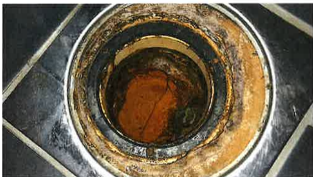
Bildet viser sluk.
