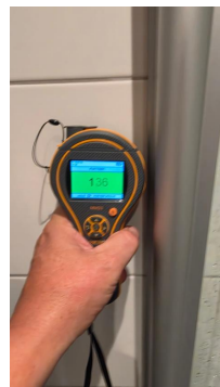
Fuktsøk med Protimeter MMS 3 utført på befaringen. Ingen fukt registrert i veggkonstruksjoner.
