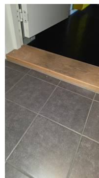
Fliser på gulv i baderom. Varmekabler i gulv.
