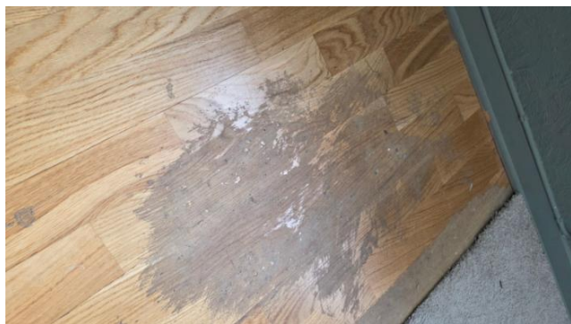
Skadet parkett overflate på ett soverom.
