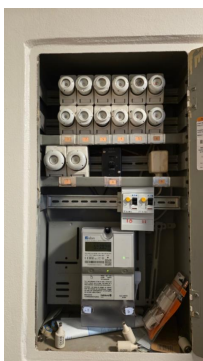
Sikringsskap med skrusikringer og nyere automatsikringer.
