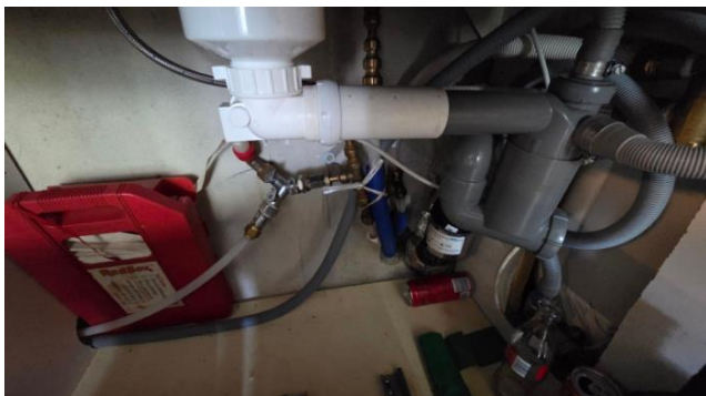
Bilde tatt i benkeskap under vask.
