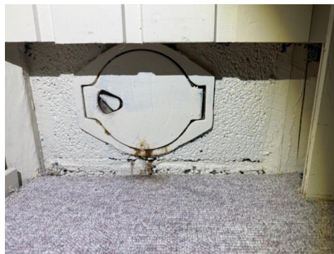
Sotluke i underetasjen
