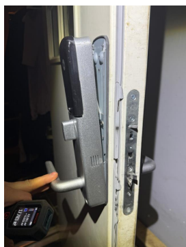
Løs låskasse på hovedytterdøra til boligen
