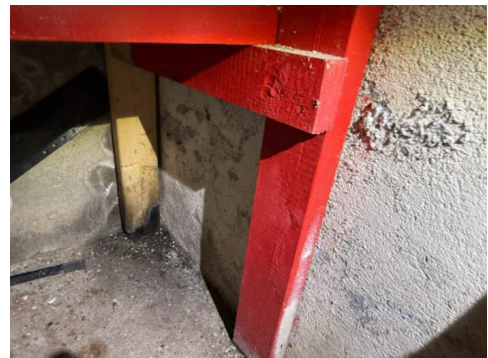
Synlig råte i møblelement, og saltutslag på vegger i garasjen i boligen
