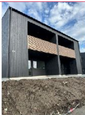
Fasade - Bygget består av 4 leiligheter.
