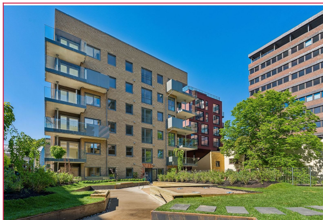
Fasade. Helt nytt bygg, ferdigstilt i 2026.
