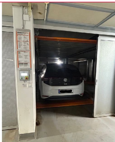
Garasje i lukket anlegg med elbillader – kan leies for tillegg på kr 1 000/mnd.
