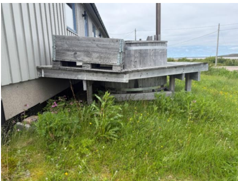
Store deformasjoner i konstruksjonen ved stampen
