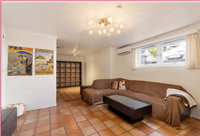
Varmepumpe i stue
