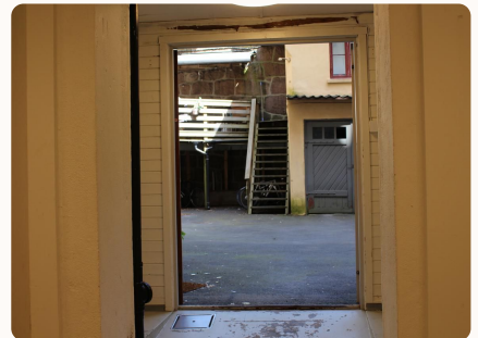
Leveringsdør mot bakgården
