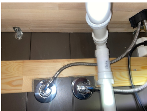
Manglende tettesjikt på rørgjennomføring.
