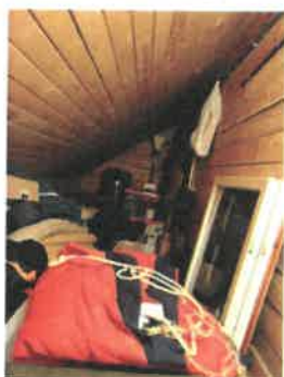
Kottrom mot sydøst med adkomst fra gang/trapperom.
