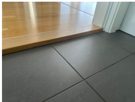
Eksempel på trapping på gulvfliser.
