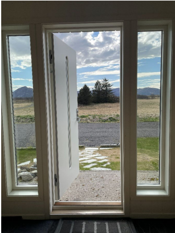
Inngangsparti «ombygd fjøs»
