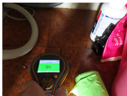
Fuktsøk i benkeskap - ingen påviste forhøyede fuktverdier.
