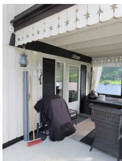
Utadslående terrassedør med isolerglass.
