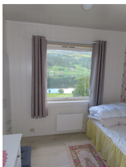
Nyoppusset soverom i 2.etg etter vannskade.
