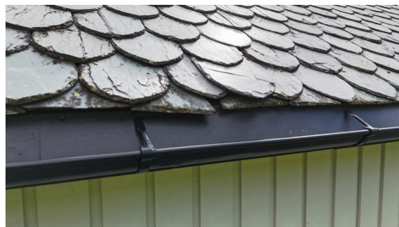
Reparasjonstiltak etter nedre takutstikk.
