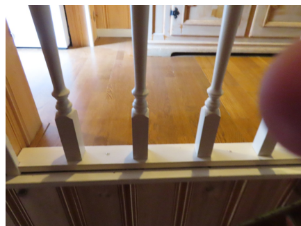
For stor avstand mellom spiler.
