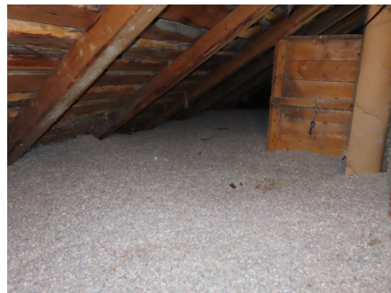
Gulv inne på kneloft er etterisolert med innblåsningsisolasjon.
