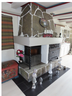
Murt gruepeis samt parafinbrenner i stue i 1.etg. (Parafinbrenner er ikke lenger i bruk-tilførsel er kuttet).
