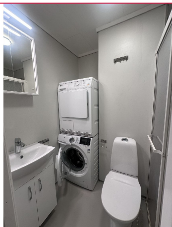
Bad - Badet blir pusset opp
