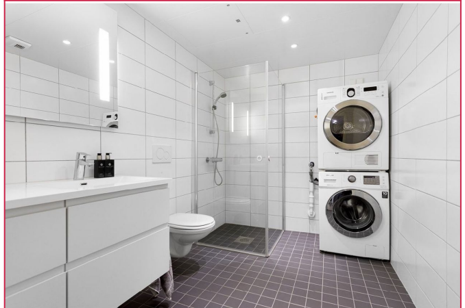
Flislagt bad med vaskemaskin og tørketrommel. Varmekabler i gulv.
