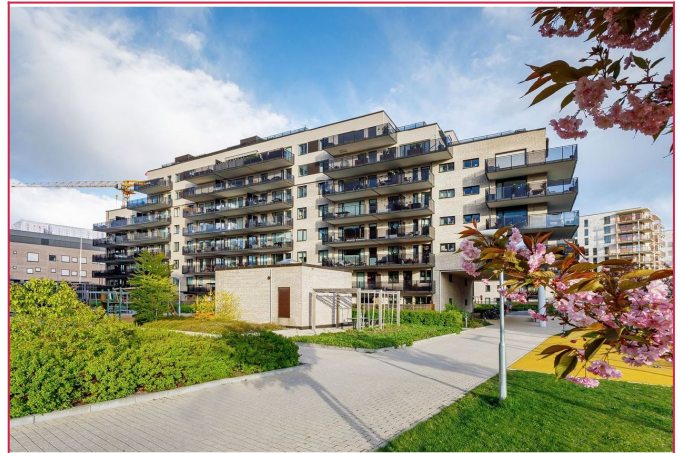
Fasade. Boligen ligger i byggets 5. etasje.
